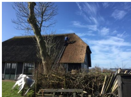
Herstel van de stormschade in februari aan de rieten daken door de firma Harry Vijver
