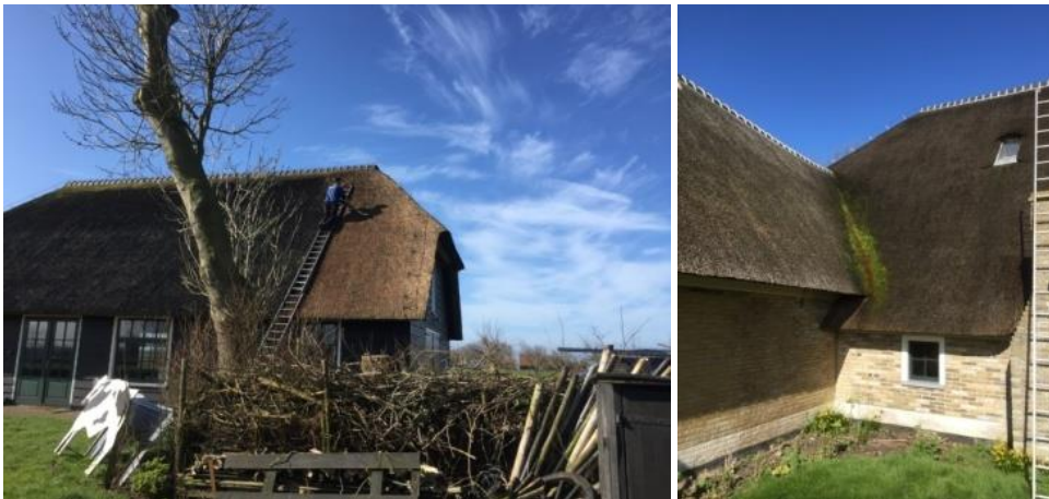
Herstel van de stormschade aan de rieten daken door de firma Harry Vijver
